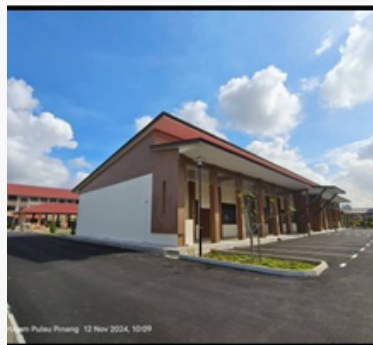
KOLEJ VOKASIONAL S.PERAI
