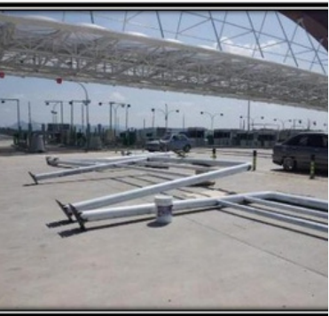
JAMBATAN KE 2 PENANG
