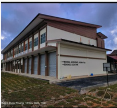
KOLEJ VOKASIONAL S.PERAI
